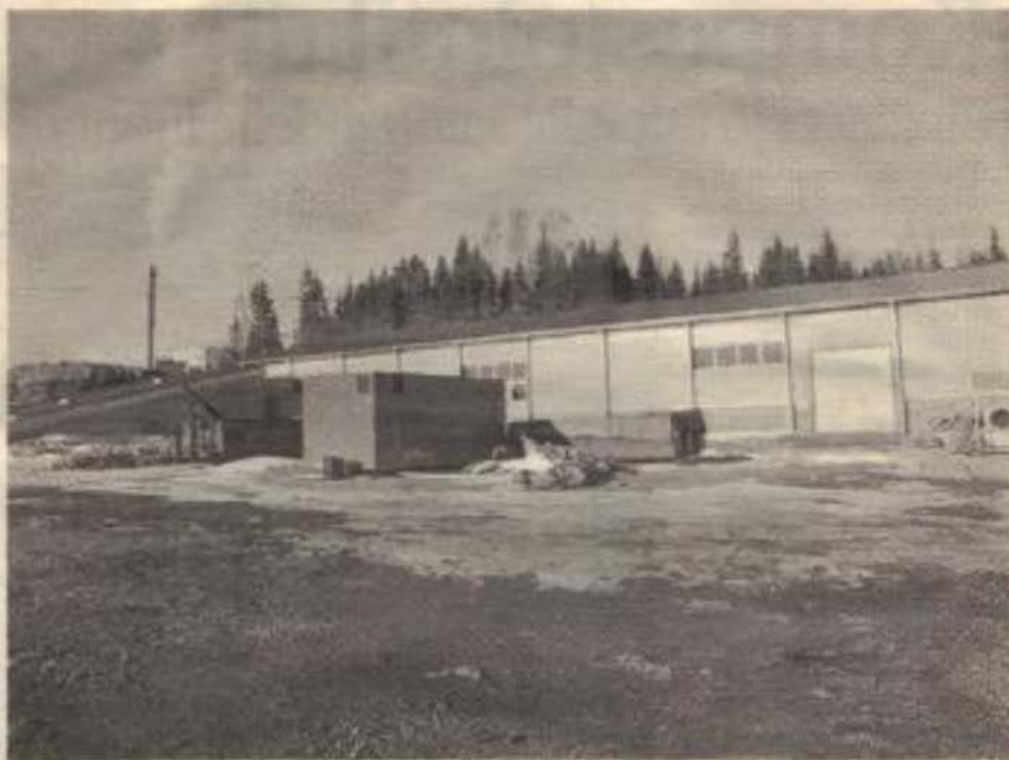
Suomen Multaravinne Oy:n kompostointilaitos täydentää merkittävästi Kilmassuon eriväite-kokonaisuutta.
